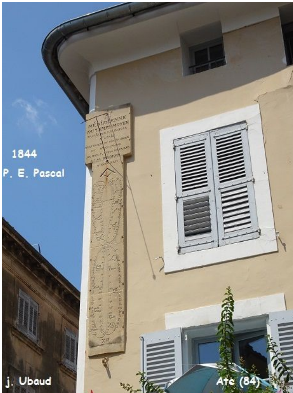
Méridienne du temps moyen tracée par P. E. Pascal d'après les tables de déclinaisons et d'équations de Dom. F. Bedos de Celles et de Berthoud
